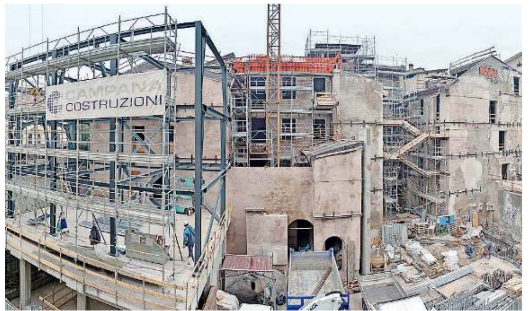
Cantiere. Nel «vuoto» è comparso lo scheletro in ferro del nuovo edificio che completerà il fabbricato storico
